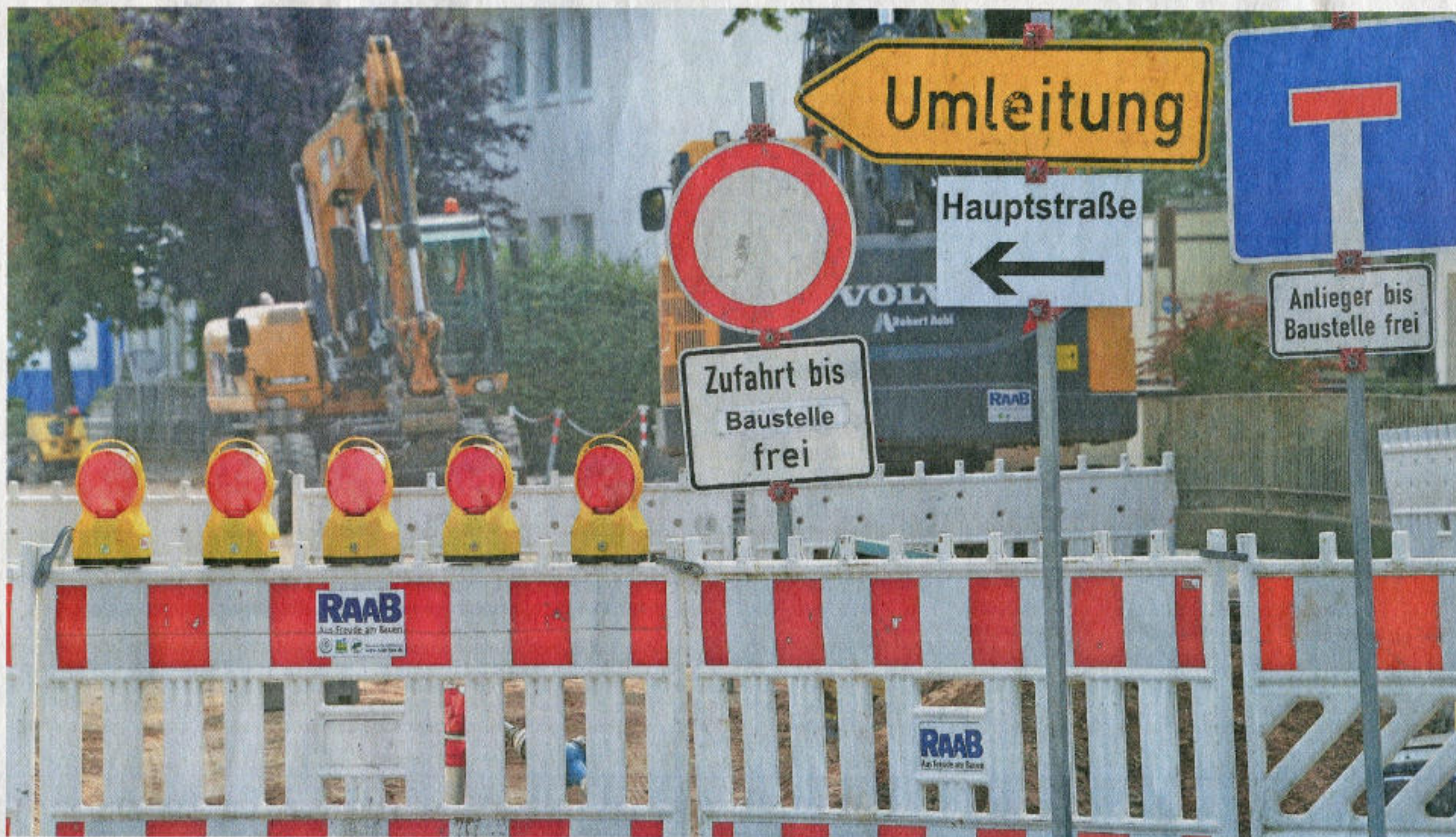
Die Baustelle „An der Schütt“: Auch hier müssen die Anwohner gemäß Straßenausbaubeitragsatzung zu einem gewissen Anteil mitzahlen.
